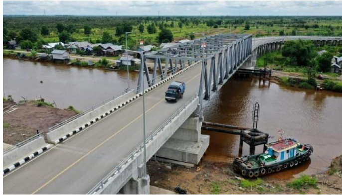
Jembatan Antang/Foto: Danang Sugianto
