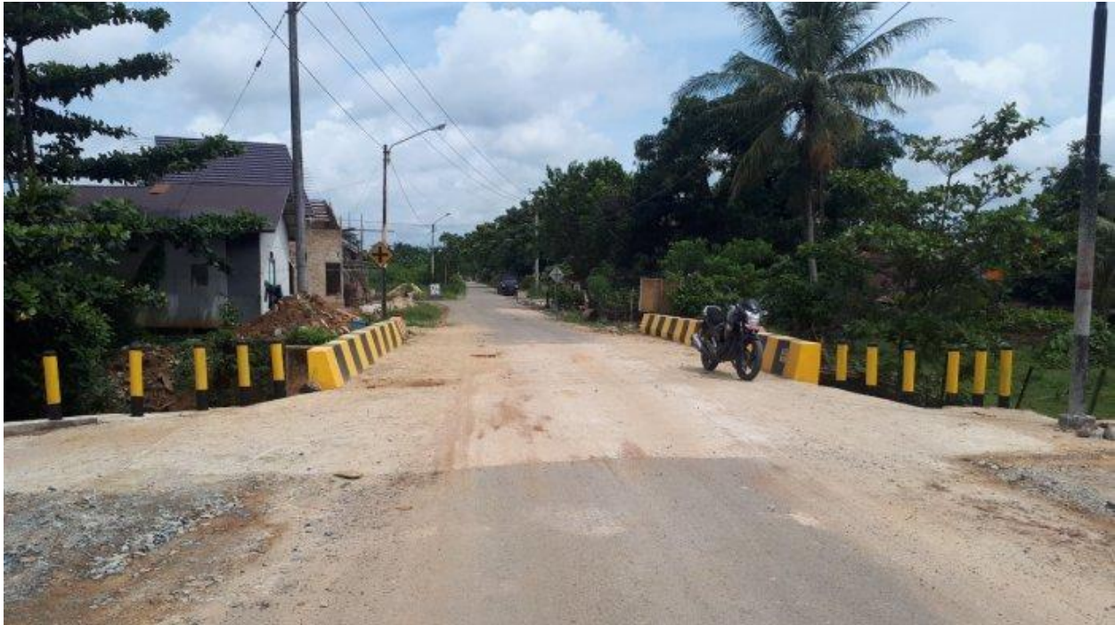
Inilah penampakan jembatan permanen di Jalan Bajingah.
