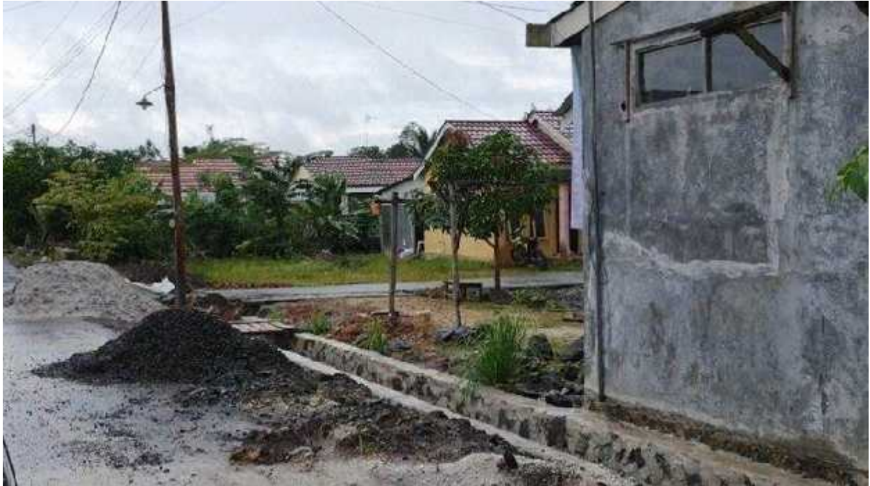
Saat pengerjaan drainase lingkungan yang hampir rampung di Kota Banjarbaru, Provinsi Kalimantan Selatan.
