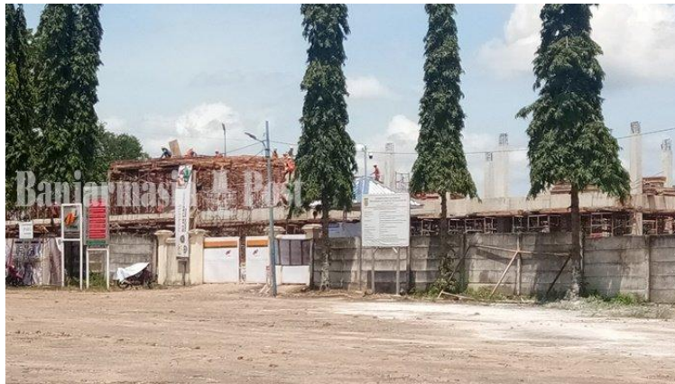
Pembangunan Pasar Bauntung di eks Stadion Mini Gawi Sabarataan, Jalan RO Ulin, Banjarbaru, Kalsel, Februari 2020
